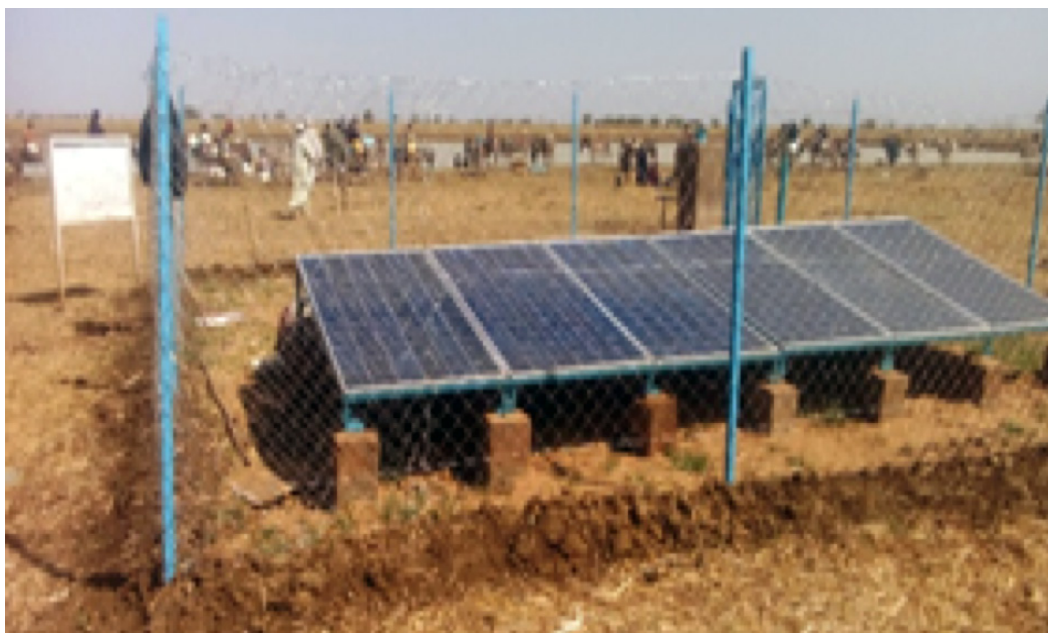
Système d'exhaure solaire pour alimenter une mare pastorale et alimenter la communauté de transhumants en eau potable
