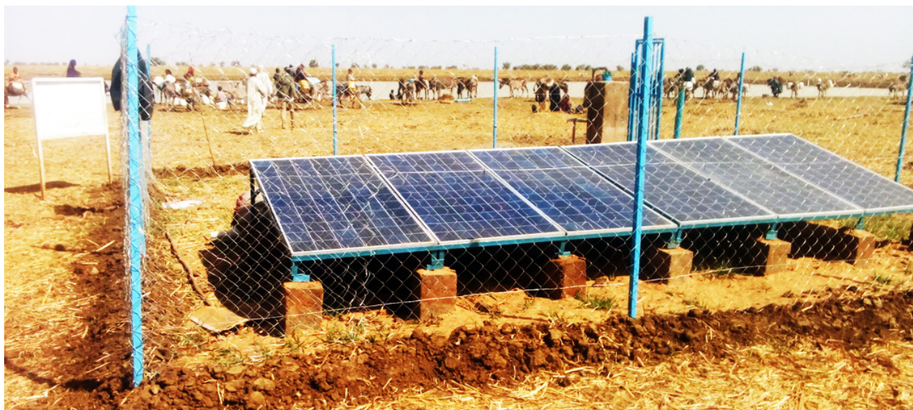
Mare pastorale dotée d'un système solaire pour abreuver le bétail et la communauté de transhumants (eau potable)
