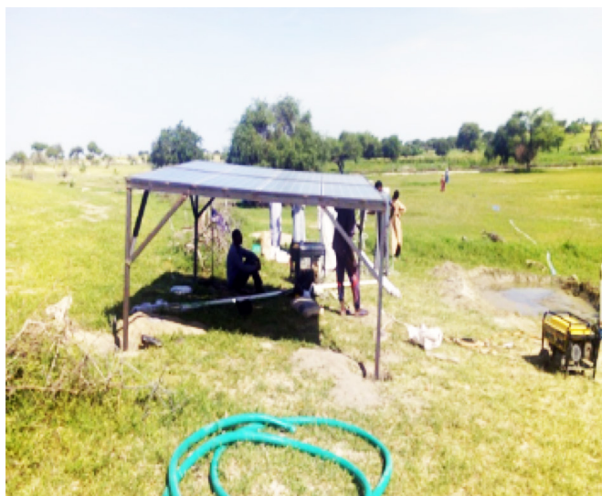
Système d'exhaure solaire pour l'exploitation des ouadis
