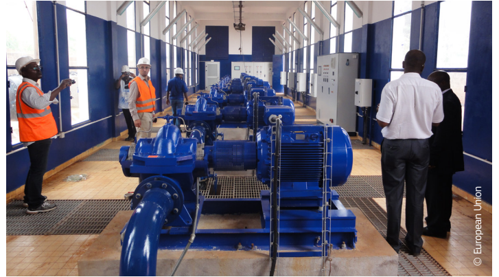
Approvisionnement en eau à Yaoundé - Projet BEI/AFD
