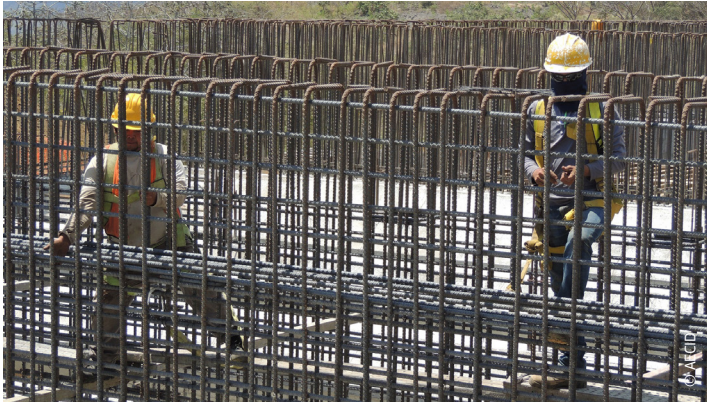
Avancement des travaux de la station de traitement des eaux usées de Masaya
