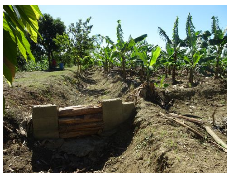
FOTO 3-3: INSTALACIÓN DE CANALES PARA EL RIEGO POR INUNDACIÓN
