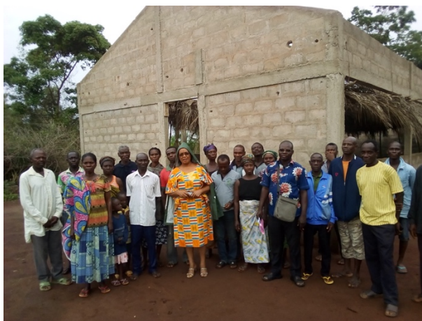
FIGURE 29. BIBLIOTHEQUE EN CONSTRUCTION A BAGBEGAN Source : Photo de l'équipe.
