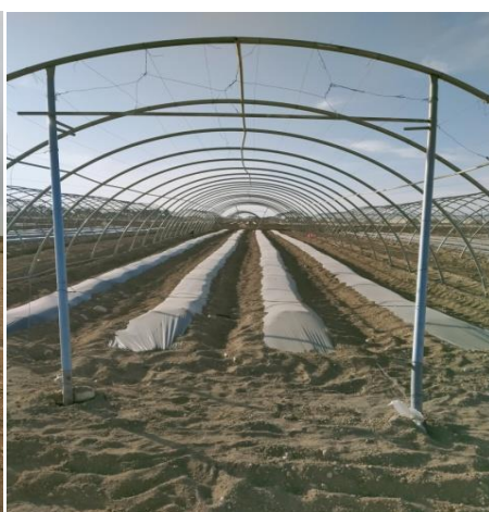
Préparation des travaux de la serre (M'ziraa)
