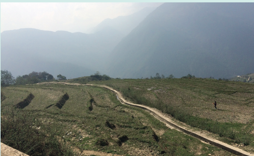
Exemple d'un site d'irrigation.
