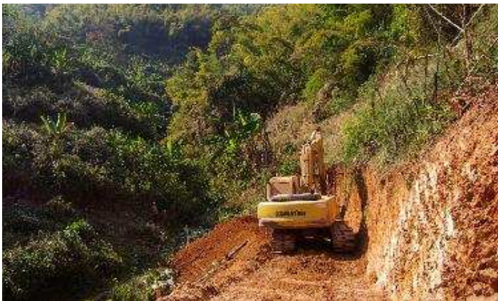
© Tommaso Cinti. Construction de route. Laos. Juin 2008.
