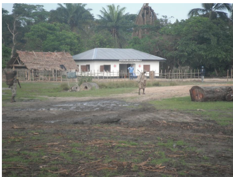
Photo 12 : SODEFOR - Dispensaire construit à Essangambala
