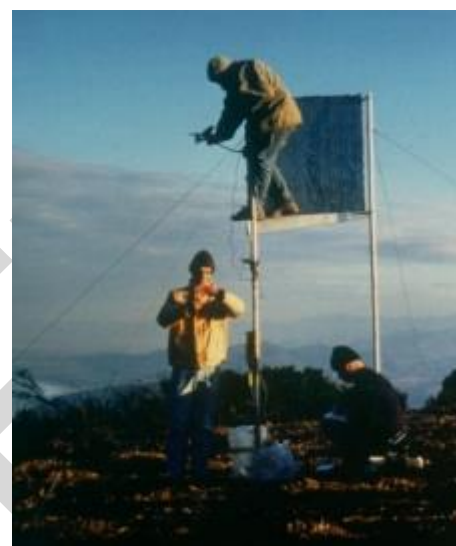
Ilustración 2. Instalación de un atrapanieblas
