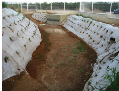
Ilustración 4. Instalación de franja de infiltración en Xàtiva, Valencia
