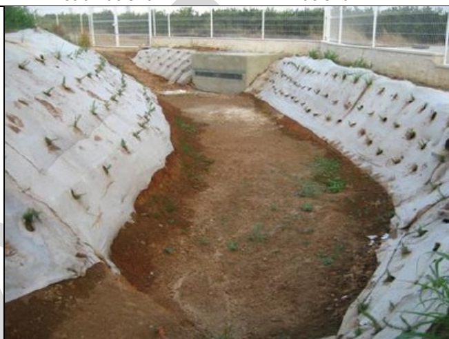
Instalación de franja de infiltración en Xàtiva, Valencia (Fuente: Perales-Momparler et al. 2013)
