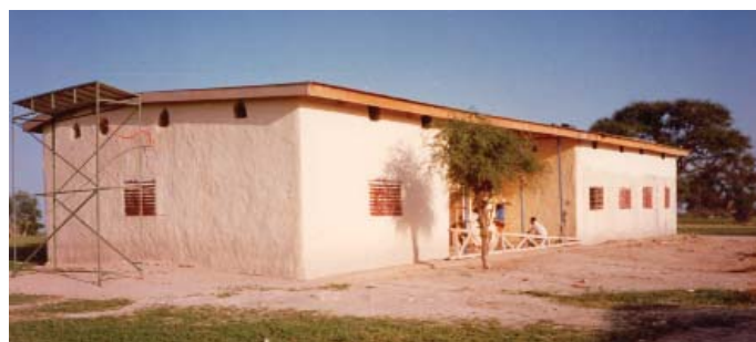
Réhabilitation du dispensaire de Motoa Kanem
