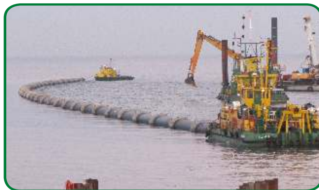
"Montaż podziemnej rury odprowadzającej" Zdjęcie: Gmina Miasta Sopot
