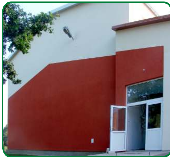
"Nowy Kompleks Sportowo-Rekreacyjny w Specjalnym Ośrodku Szkolno-Wychowawczym w Węgorzewie" Zdjęcie: Powiat Węgorzewski
