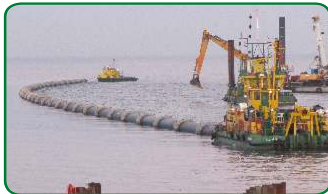
„Установка подземного трубопровода“ Фотография: муниципалитет г. Сопот
