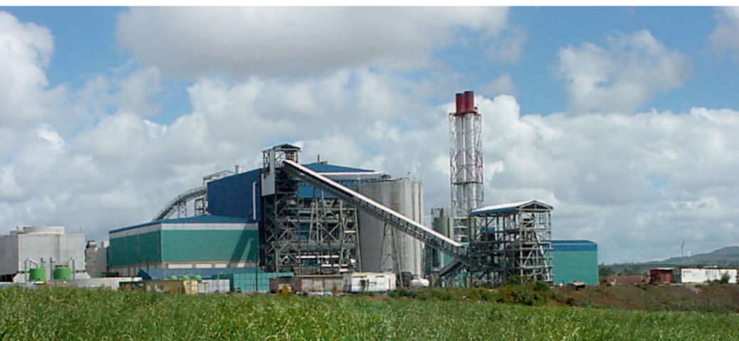
Electricity and liquid biofuels are produced by the sugar industry at the hybrid bagasse coal power plant in Mauritius. De l'électricité et des bio carburants liquides sont produits par l'industrie sucrière à la centrale hybride de Maurice alimentée par de la bagasse et du charbon.
