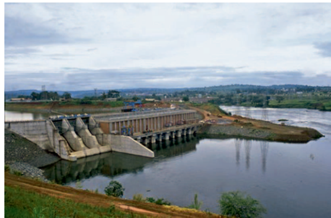
The hydroelectric installation at Owen Falls provides Ugandan industry and western Kenya with electrical power. L'installation hydroélectrique Owen Falls fournit du courant électrique au secteur industriel ougandais et au Kenya occidentale.
