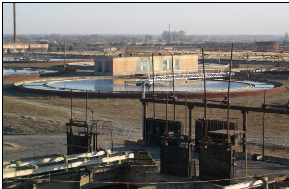
Рисунок 0-1 Песколовки и первичные отстойники на Гардабанских КОС в работе
