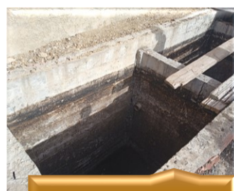
Bassin de décantation
