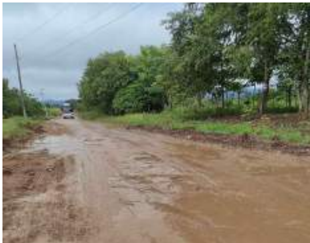
Condiciones actuales de la vía objeto del proyecto
