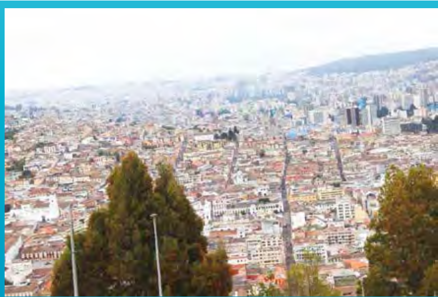
Centro Histórico de Quito, Ecuador (fotografía equipo UAZ, 2023)
