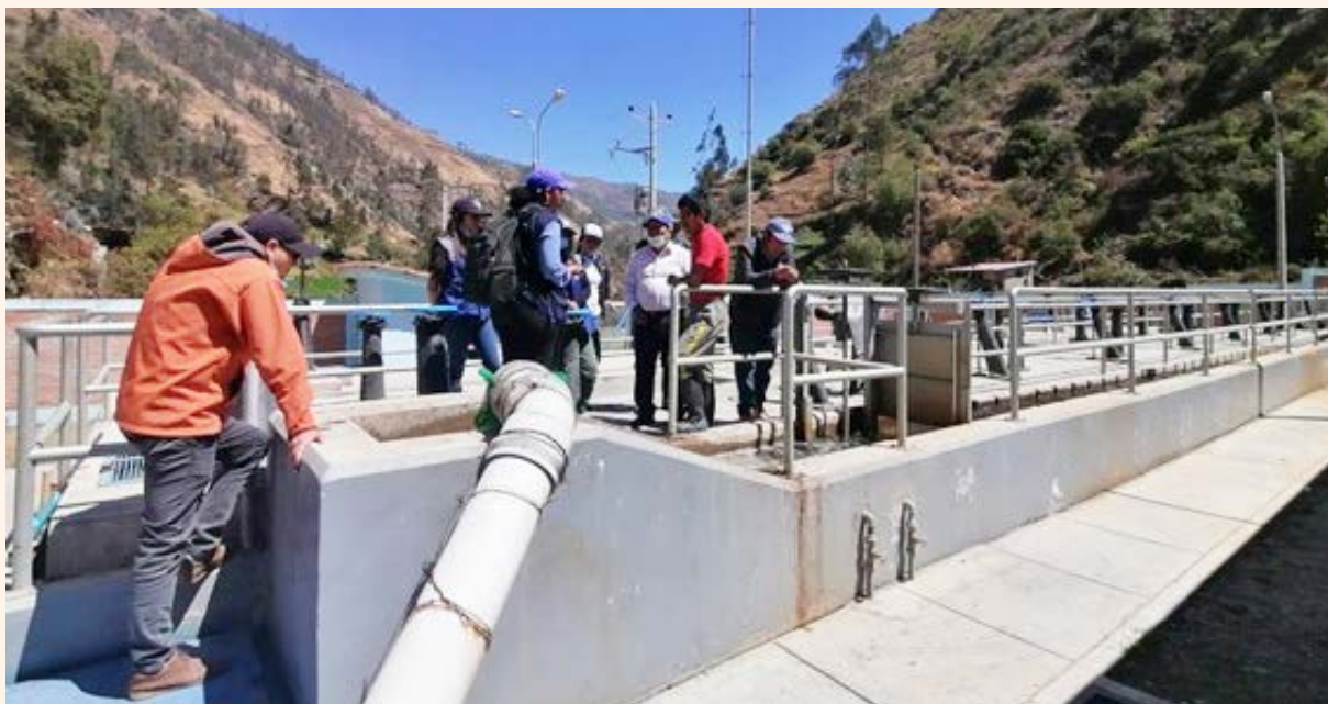
Figura 30. Capacitación Planta de Tratamiento de Agua Potable.
