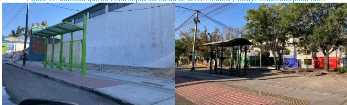
Figura 49. Corredor que se viene implementando en la Av. Aviación, incluye señalética podo táctil
