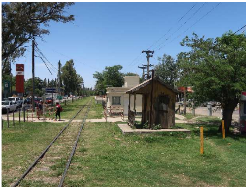
Ilustración 97 – Cruce ferroviario sin protección ni barreras. (elaboración propia para el PMUS).
