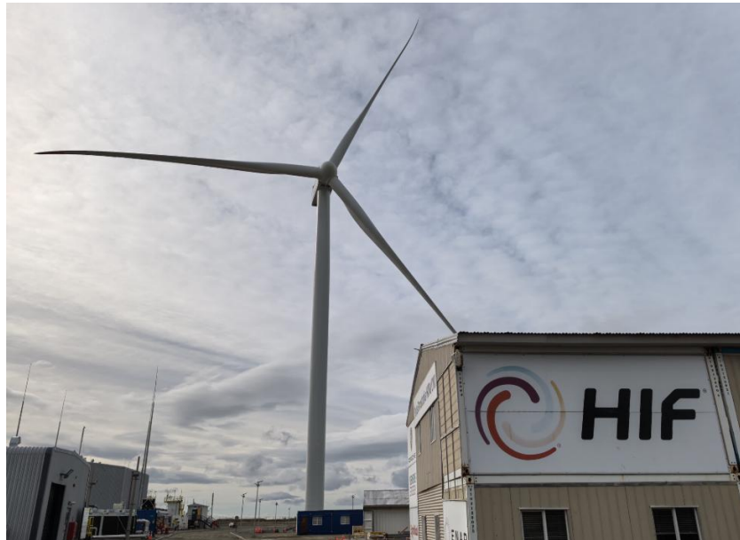
Figura N°148 Turbina eólica de proyecto HIF en la región de Magallanes, Chile.
