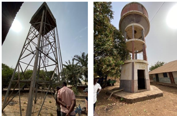
FIGURA 35 | FUROS E RESERVATÓRIOS DESACTIVADOS DE MANSOA
