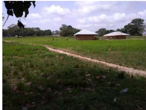
Vista da escola (2 edifícios)
