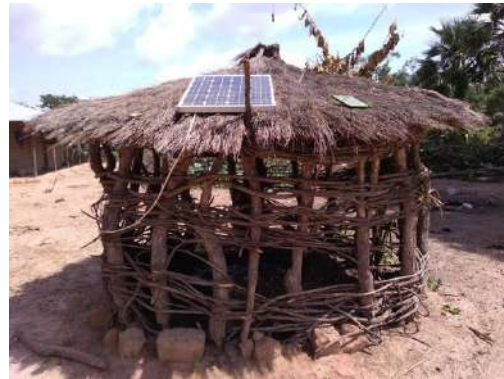
Residência com SHS
