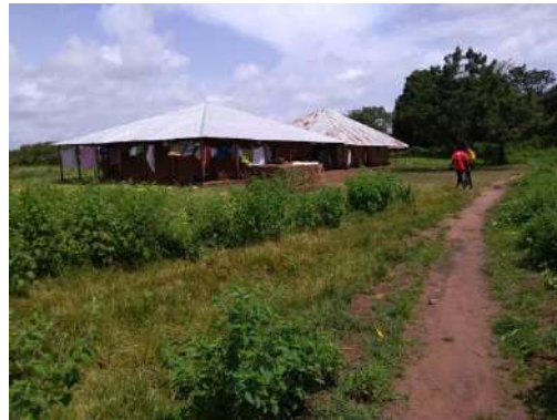
Residências (sem SHS)
