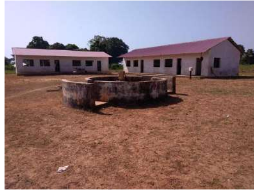
Escola (edifício 2 e 3)
