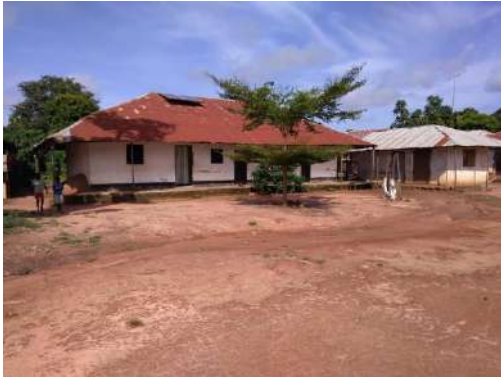
Residência com SHS
