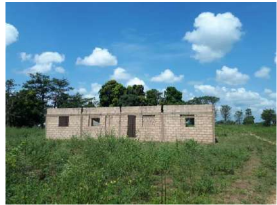
Escola (em construção)
