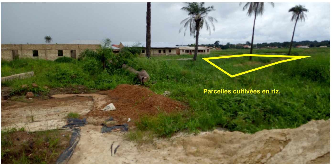
Annexe 6 : Maisons en cours de construction dans un bolanha (Sadousty, 2019)
