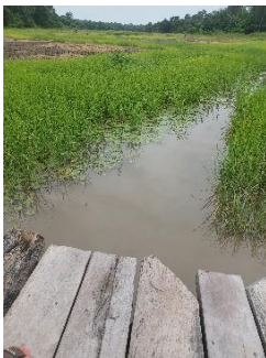
Foto 23: Canalização de água na bolanha de Bunancare (M. Roudaut, 13/10/2023).
