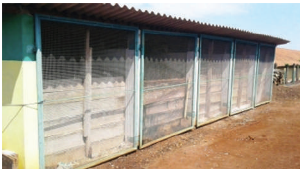
FIGURA 4.60 – Instalações de compostagem.
