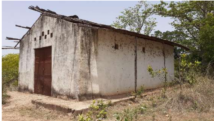
Foto 3: Armazém para materiais de trabalho agrícola, descrito como não tendo uso atualmente
