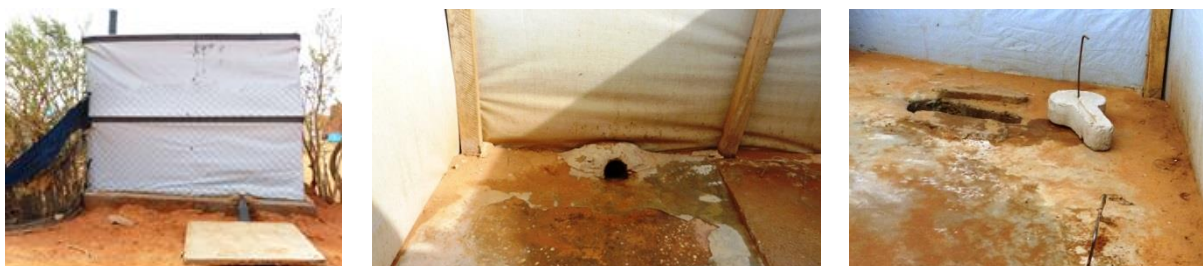
Bloc latrines+ douche du camp de Mbéra vue de dos (à gauche), espace douche (centre) et toilette (droite)
