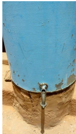
CRENAS de Cénéa : postes de lavage des mains hors d'usage et partiellement cannibalisés (robinets retirés)
