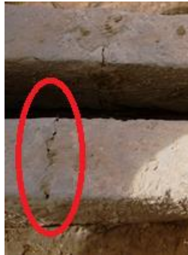
Ngoui (IRC/ECHO) : conséquence de ces techniques inadaptée : rupture du canal de drainage.
