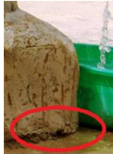
Ngoui (IRC/ECHO) : conséquence de ces techniques inadaptée : érosion de la base de la pompe avec risque de contamination du forage.
