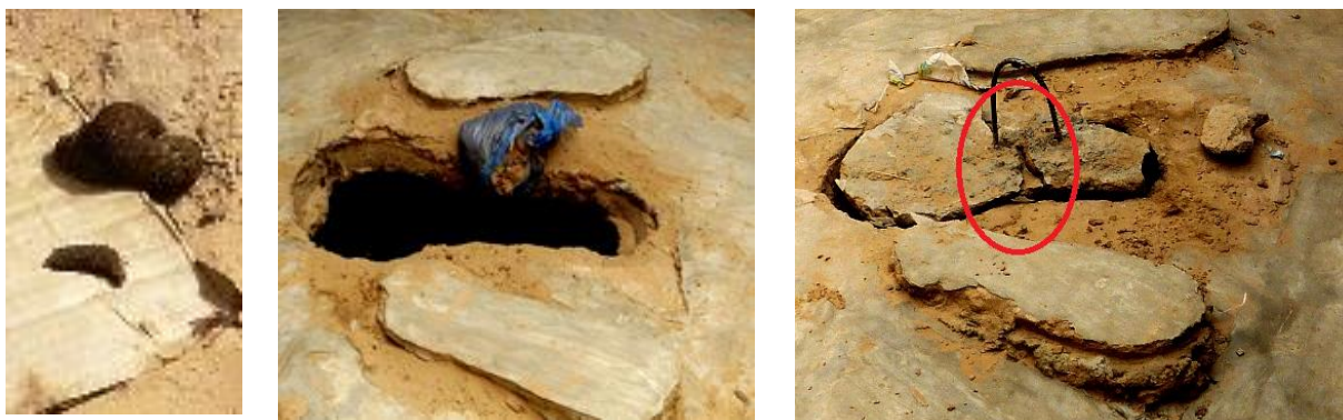
Ngoui (IRC/ECHO) : La présence d'excréta autour du trou de défécation met en évidence l'usage des latrines utilisées a priori comme poubelles plutôt que comme lieu de défécation (photo de gauche et du milieu). Les techniques employées dans la réalisation des latrines sont inadaptées (photo de droite : couvercle du trou fendu suite à l'emploi de sable trop fin, sous dosage en ciment et modèle inadapte car trop lourd).
