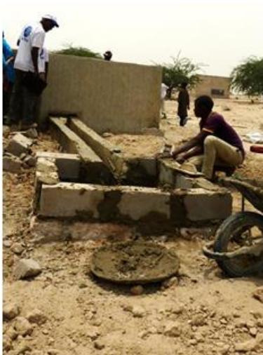
Guetoulou (ACTED/ECHO) : Technique (briques et mortier projeté) et matériaux (sable trop fin, ciment sous dosé) inadaptés aux ouvrages hydrauliques
