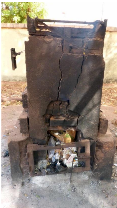
A Gauche : CScOm de Pélangana-Sud : ancien incinérateur dervant de poubelle à des déchets médicaux.
