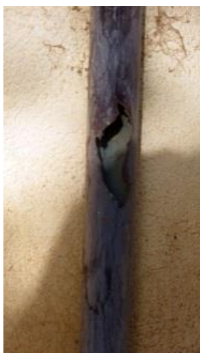
Latrine de l'URENI de Ségou : dalle de latrine descellée et tuyau d'aération percé ne permettant pas l'isolation de la fosse du milieu ambiant
