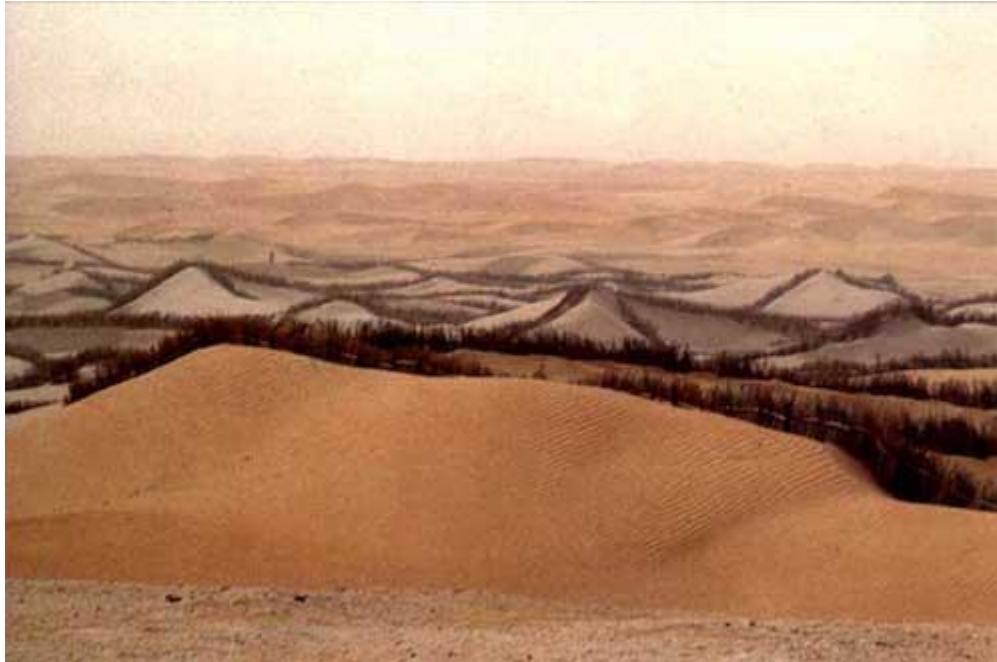
Stabilisation mécanique le long de la route de l'Espoir (p.K.23) dans la province du Trarza (Mauritanie). Photo René Grojean.
