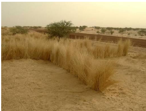
Travaux de fixation des dunes.
