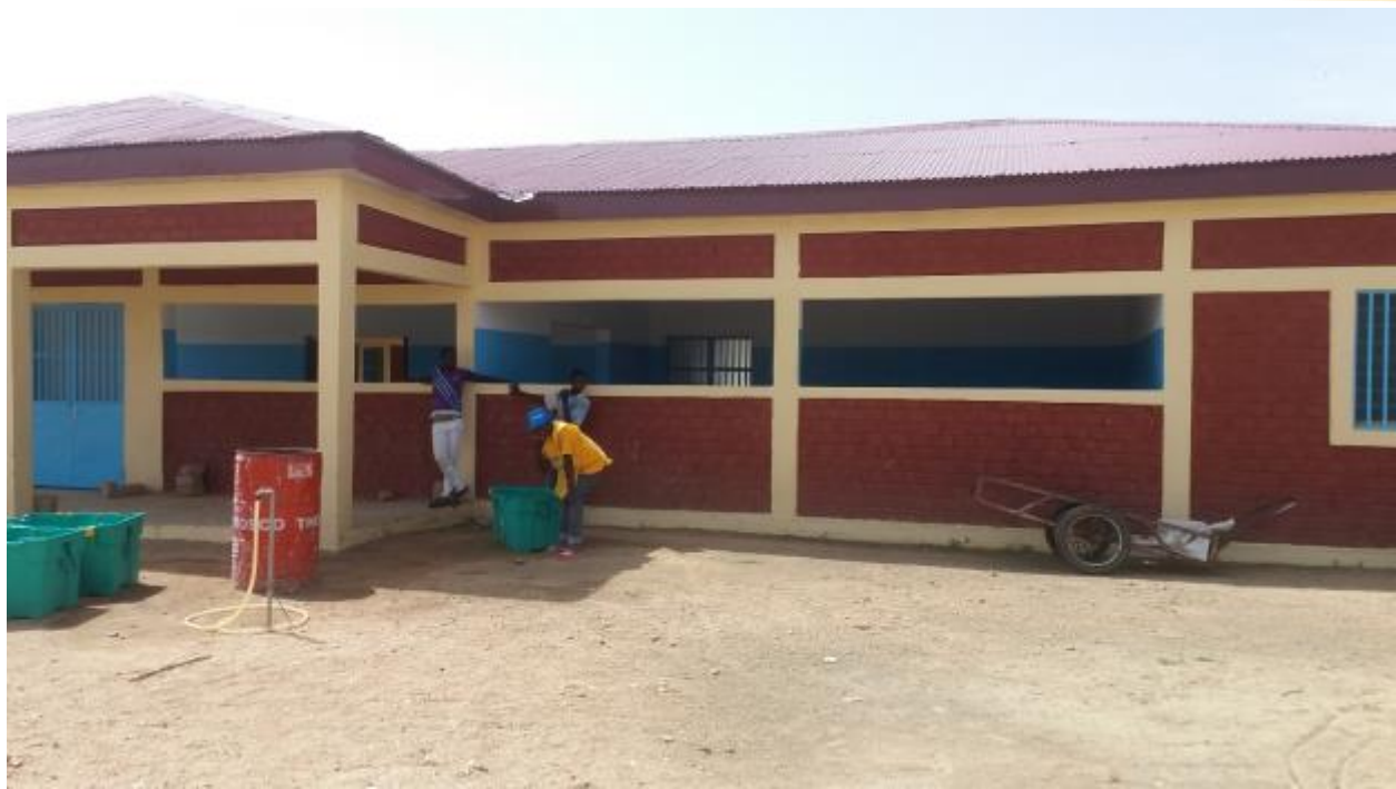
Centre de santé construit en brique en terre stabilisée (BTS) au camp des réfugiés de MINAWAO région de l'Extrême-Nord Cameroun
