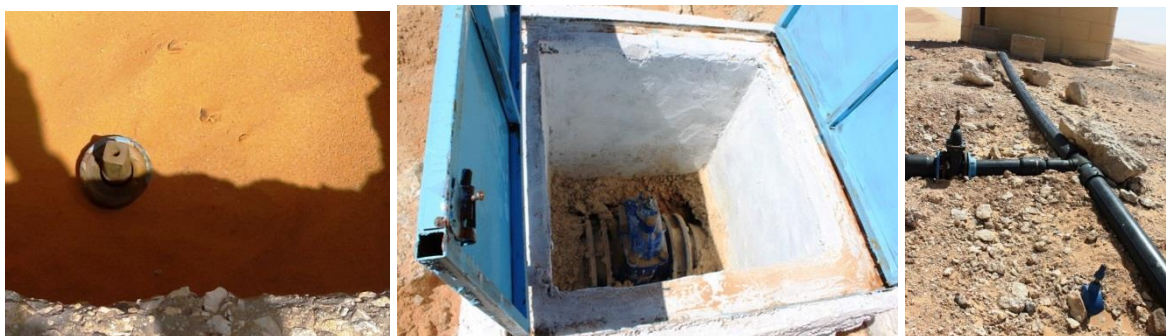
De gauche à droite : Ensablement des vannes de contrôles à Dakhla, Laayoune et Ausserd (enfouies).
