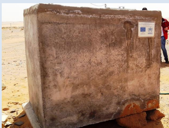
Exemple d'un réservoir en ferrociment à Dakhla. Outre la qualité discutable d'exécution, l'assise non consolidée du réservoir risque à terme de menacer sa structure interne
