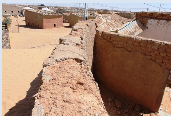
Ci-dessus (Ausserd) : Le comblement de rue est également un phénomène observable à Ausserd où la présence de sable n'est avérée que dans la ville A droite du mur d'enceinte, le niveau du sol de la concession renseigne sur le niveau de la rue (à gauche) avant ensablement.
