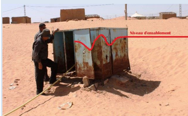
Ci-dessus (Ausserd) : l'ensevelissement de la prise sur le réseau à conduit le HCR à dégager la prise à la pelleuse. Les traces de rouilles sur le poste témoignent du niveau atteint par le sable avant dégagement
