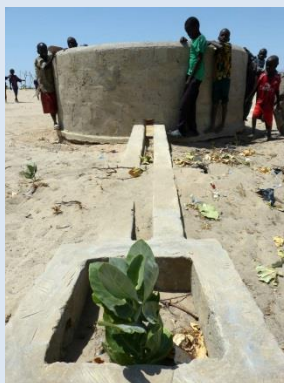
Canal de drainage ensablé et érosion anormale à la base de l'ouvrage
