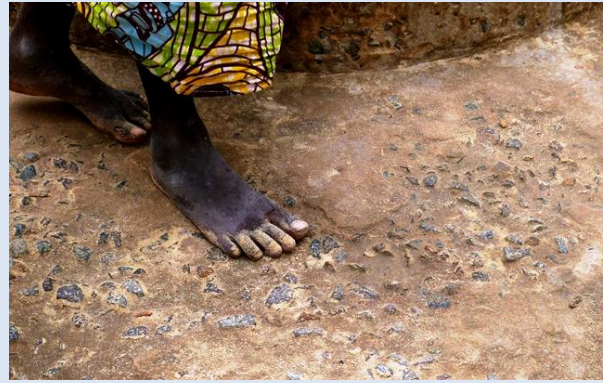
Sous-dosage en ciment et utilisation de matériaux inappropriés conduisant à une érosion accélérée de la dalle aussi bien côté humide (pompe) que côté sec (levier)
