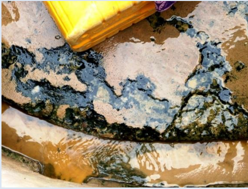
Sous-dosage en ciment et utilisation de matériaux inappropriés conduisant à une érosion accélérée de la dalle aussi bien côté humide (pompe) que côté sec (levier)
