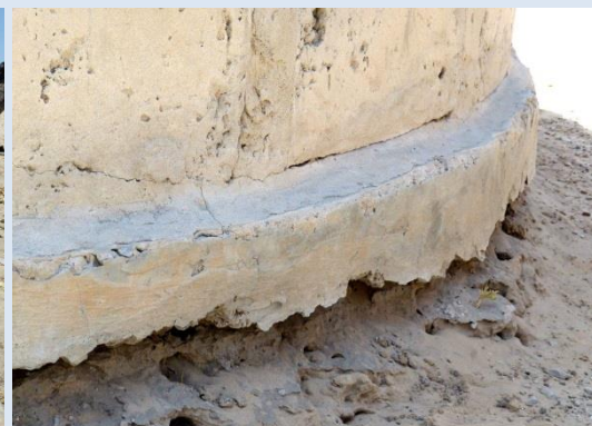
Canal de drainage ensablé et érosion anormale à la base de l'ouvrage
