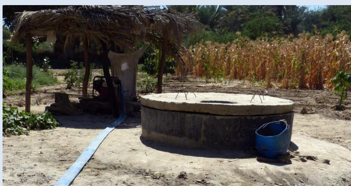
Double système d'exhaure : un forage motorisé et un puits manuel en cas de panne de la motopompe
