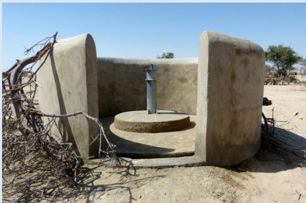
Ouvrage terminé mais fermé en attendant que le béton de l'aménagement de surface ne se consolide.
