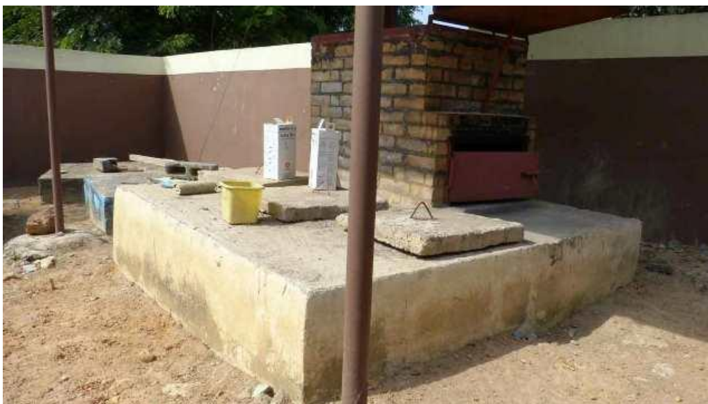
Incinérateur de Biantouo 2 et ancienne fosse à placenta et déchets mis en place par COOPI (arrière plan).
