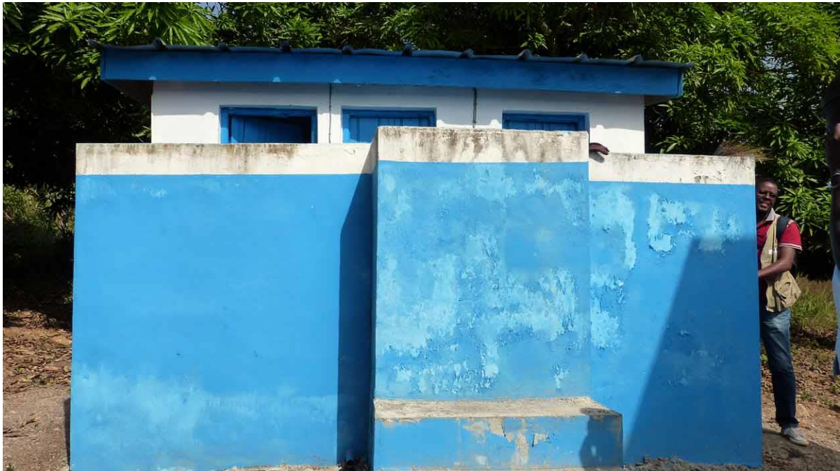
Latrine de l'Etablissement de Santé de Premier Contact (ESPC) de Gbatongoin (District sanitaire de Man, Région des Montagnes)
