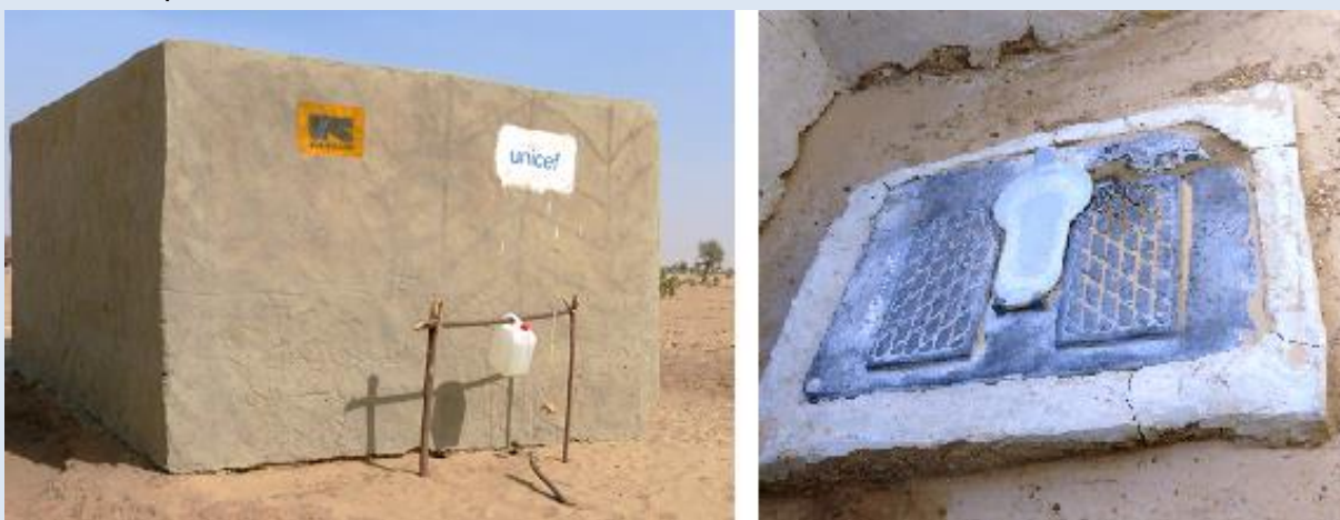
Mainiakadéri : poste de deux latrines et trou de défécation à l'intérieur correctement isolé avec des dalles NAG
