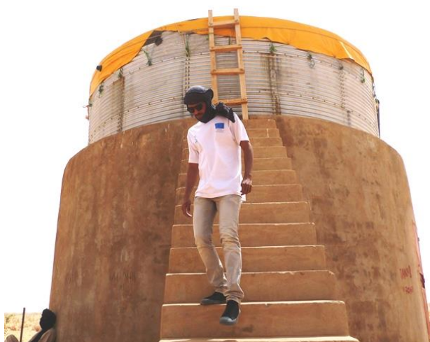
Réservoir tampon de M'Béra 2 alimenté par le réseau du camp et desservant 12 bornes fontaines dans le village hôte.
