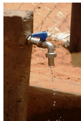
Fuite sur une borne fontaine directement raccordée au forage
