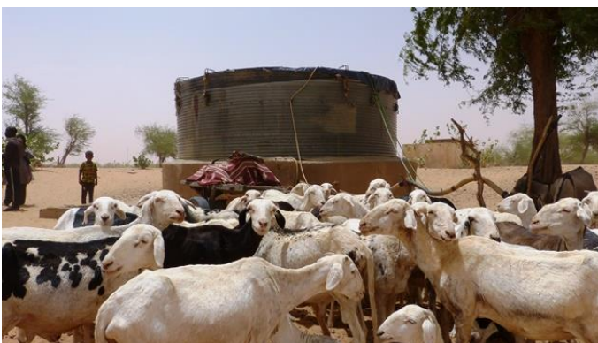
Réservoirs de stockage de l'ancien réseau d'AEP de M'Béra 2
