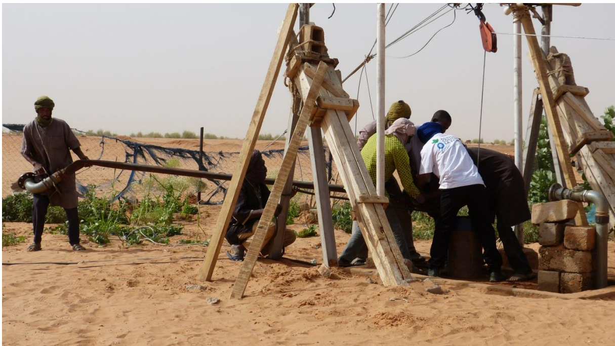
Opération de maintenance approximative du forage n°1 dans le camp de M'Béra
