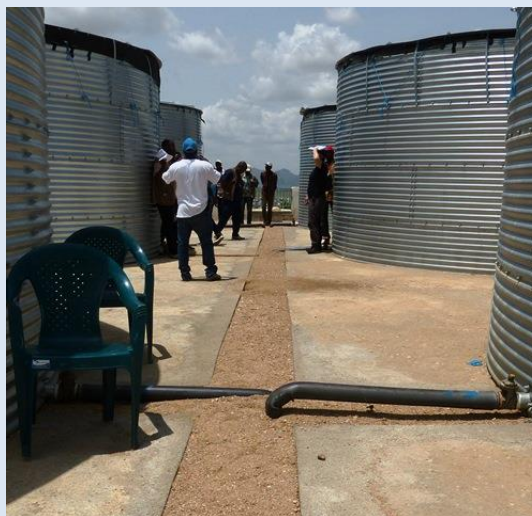
Ligne de distribution des 6 réservoirs du principal site de stockage d'eau de Minawao
