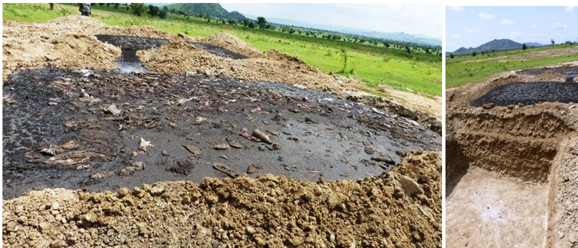
dessus : Site d'enfouissement des eaux noires du camp de Minawao avec un système sommaire de décantation des boues
