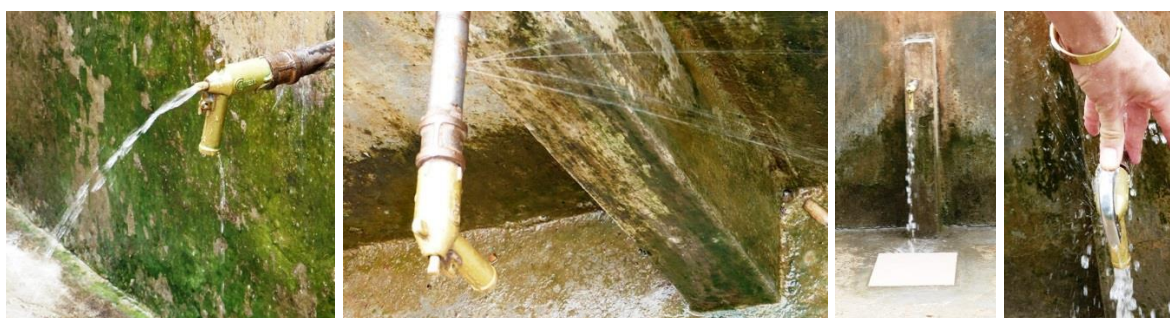
Camp de Lolo : puits perdus dysfonctionnels et absence de maintenance sur les corps de pompes (écrou et boulon manquant)
