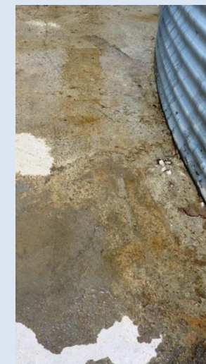
Fuite sur le réservoir plein parmi les six du site
