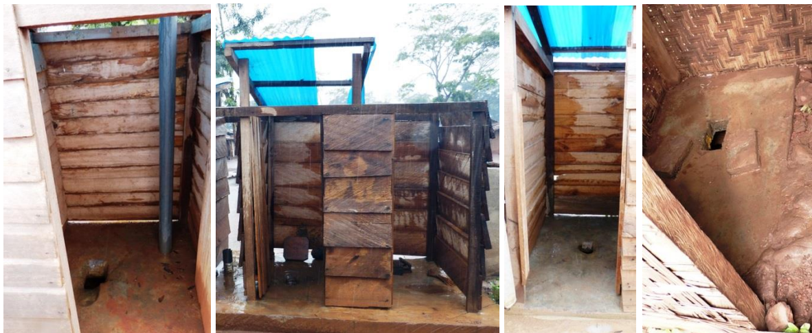
Ci-dessus de gauche à droite (Lolo): Latrine improprement conçue (gauche) avec le tuyau d'aération situé à l'intérieur de la cabine. Suivante : Toit partiellement arraché et non réparé. Les deux dernières : Absence de couvercle sur les trous de défécation.
