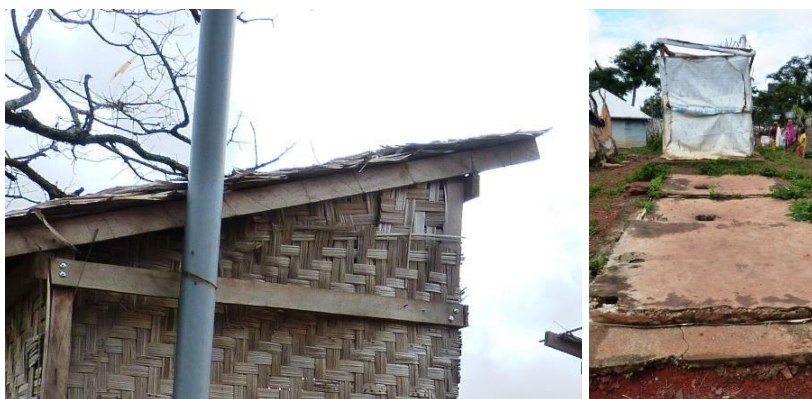
Ci-dessous (Gado): Tuyau d'aération insuffisamment arrimé à la structure (gauche) et absence de démantèlement des infrastructures une fois rendues inutilisables créant un risque sanitaire (droite)
