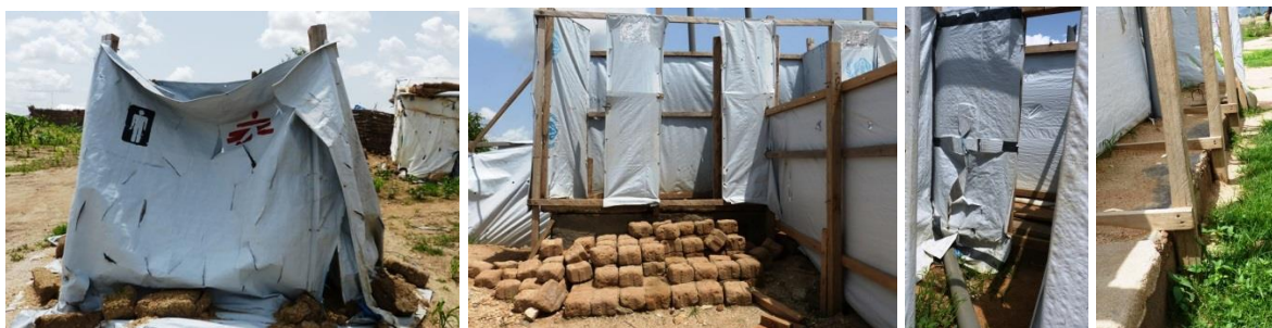
De gauche à droite : Latrine d'urgence (centre de transit) et latrine familiale insuffisamment consolidée en surface. Deux photos de droites : ancienne latrine d'urgence laissée en l'état dans le camp.
