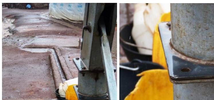
Camp de Lolo : puits perdus dysfonctionnels et absence de maintenance sur les corps de pompes (écrou et boulon manquant)
