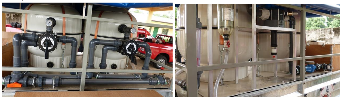
Poste de traitement avec la floculation en lignes et les filtres à sable et à charbon actif à gauche de la remorque (gauche) et le dispositif de chloration en aval à droite (droite).
