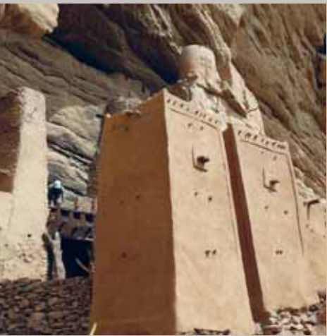
Ci-dessus : Travaux de restauration sur la Gin'na principale du village de Banani Amou
