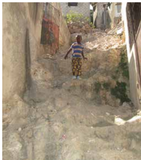
Haut-Georges Avant réaménagement en escaliers
