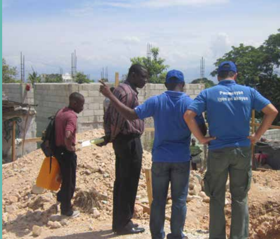
Lien avec les institutions locales Le maire visite les travaux à Grand Ravine
