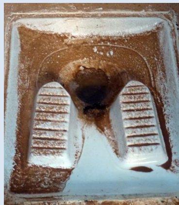
Latrine obstruée (gauche) ou ensablée (droite) rendues inutilisables en l'absence de plan de maintenance des infrastructures sanitaires
