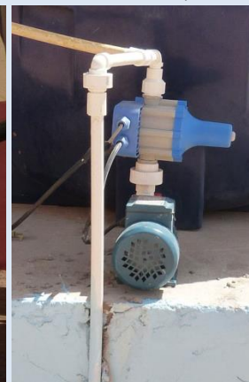
Lavabo externe au cuisine raccordé au surpresseur (à gauche) et surpresseur non protégé contre les aléas climatiques (à droite) mis en place dans le cadre de l'action.
