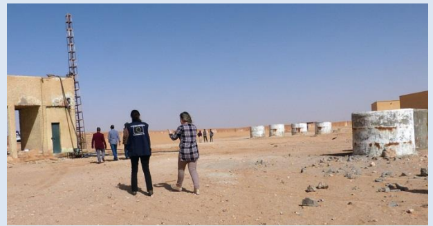
Réservoir de 60 m 3 (édifice à gauche) et citerne de 3m 3 (à droite) alimentant en eau l'école.
