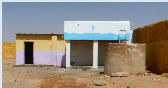
Bloc latrine (à gauche) et réservoir de stockage au-dessus du bloc (à droite) réhabilité par CISP dans l'école d' Undraiga (Camp de Laayoune)
