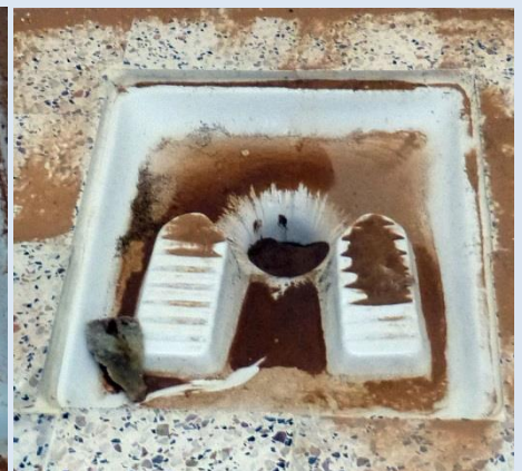
Latrine obstruée (gauche) ou ensablée (droite) rendues inutilisables en l'absence de plan de maintenance des infrastructures sanitaires
