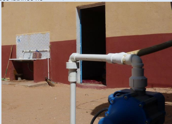
Lavabo externe au cuisine raccordé au surpresseur (à gauche) et surpresseur non protégé contre les aléas climatiques (à droite) mis en place dans le cadre de l'action.
