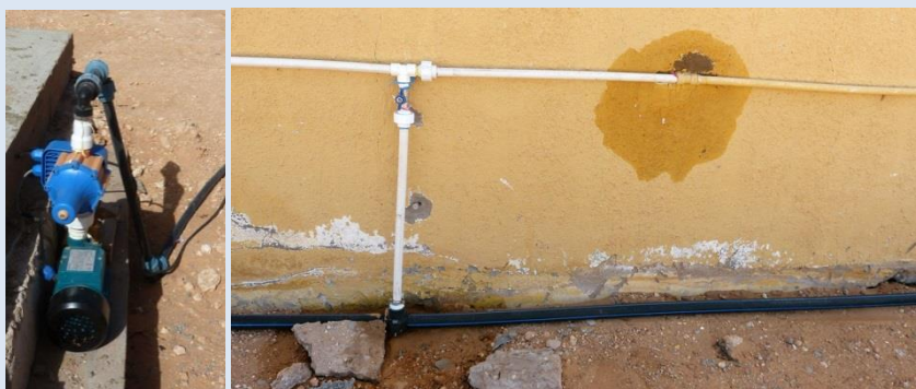
Pompe de relèvement exposée aux aléas du climat, compromettant à terme sa durabilité (à gauche) et fuites percolant à l'intérieur de la cloison en adobe compromettant à terme son intégrité (à droite)
