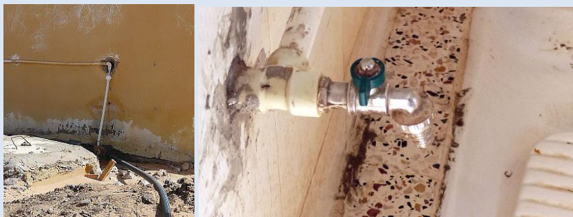
Pompe de relèvement exposée aux aléas du climat, compromettant à terme sa durabilité (à gauche) et fuites percolant à l'intérieur de la cloison en adobe compromettant à terme son intégrité (à droite)
