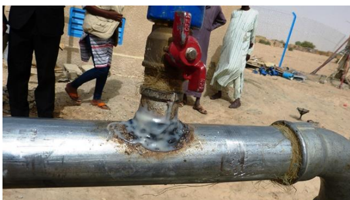
A gauche : Malfaçon au niveau du raccord de la ventouse (au-dessus) et de la tête de forage mise en place par ACTED. A droite : dispositif plus conforme aux spécifications requises (ouvrage F1 de ACF)
