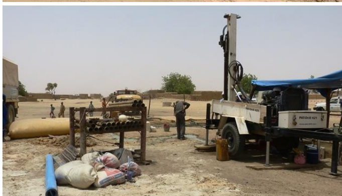
Forage en cours sur le site de Youwa au moment de la visite. L'encadrement et l'organisation du site sont conformes aux spécifications techniques attendues pour ce type de chantier.
