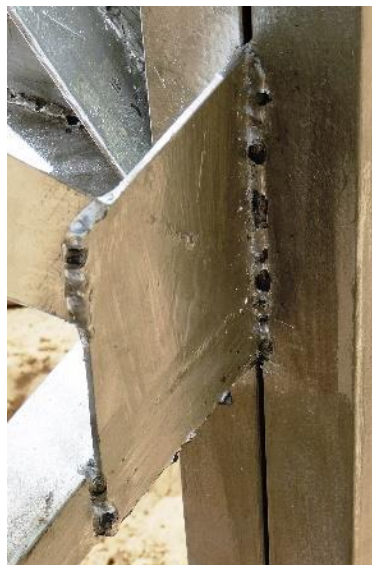
Réservoir insuffisamment élevé et soudures de mauvaise qualité le long de sa plateforme
