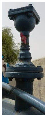
A gauche : Malfaçon au niveau du raccord de la ventouse (au-dessus) et de la tête de forage mise en place par ACTED. A droite : dispositif plus conforme aux spécifications requises (ouvrage F1 de ACF)
