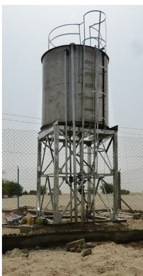
Réservoir insuffisamment élevé et soudures de mauvaise qualité le long de sa plateforme
