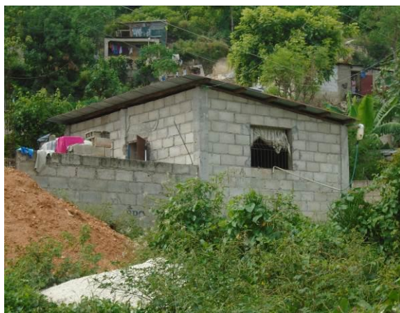
Figure 44 : citerne individuelles d'eau de pluie
