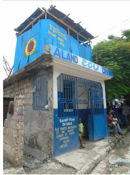
Figure 34 : point de vente d'eau traitée par osmose à Barreau
