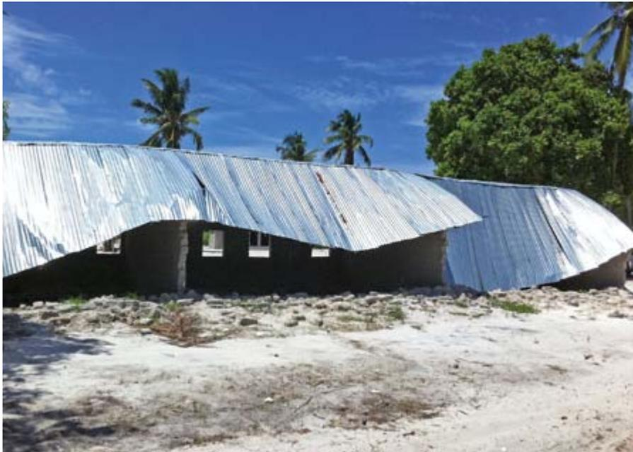
Figure 11 : Une construction de mauvaise qualité ou la faible prise en compte de l'exposition au risque peuvent résulter en des dommages structurels importants, comme on le voit ici au Mozambique
