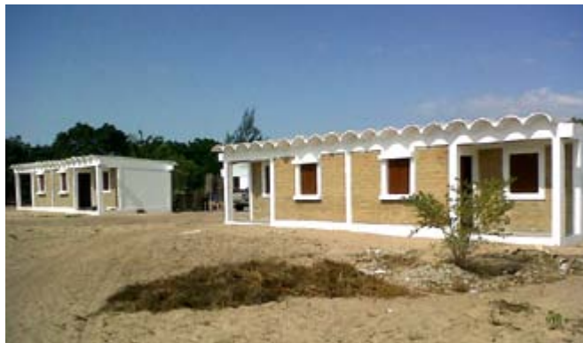
Figura 19 (esquerda): Abrigo resistente a ciclones construído com materiais tradicionais.
