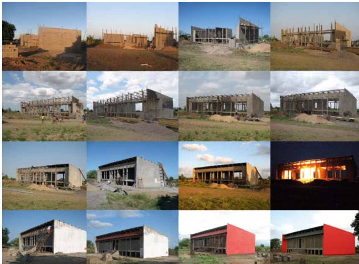
Figura 13: Diferentes fases da construção da escola elevada resistente a cheias, em Maniquique, Moçambique.
