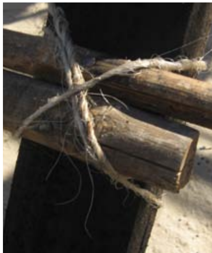
Figura 9: Técnica simples usando material local para aumentar a resistência a ciclones.
