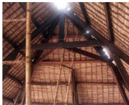
Figura 7: Abrigo comunitário resistente a ciclones construído por CARE em Fenerive, Madagáscar.
