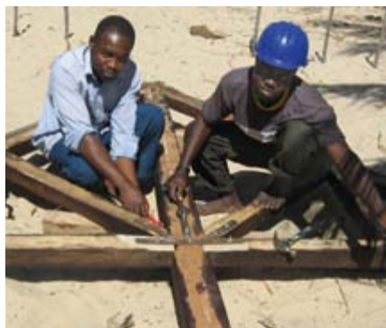
Figura 8: Construtores locais aplicaram técnicas de construção resistentes a calamidades em Angoche.
