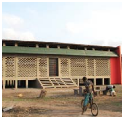
Figura 21: Edifício com plataforma elevada para fins diferentes construído com materiais convencionais.
